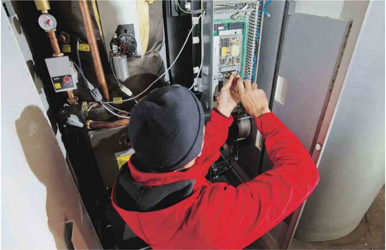
Entretien d'une chaudière à gaz par un technicien chauffagiste.
